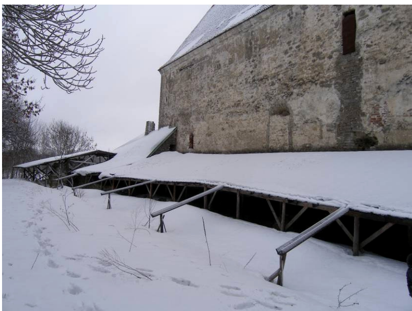
5. Vaade varikatusele. Esiplaanil näha olevad veesülitid ei toimi, kuna katusekate ja räästapealsete püstrennide katted on amortiseerunud
